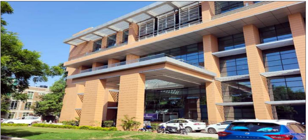
प्रौद्योगिकी भवन, नई महरौली रोड, नई दिल्ली में विज्ञान और प्रौद्योगिकी के विकास के नए अत्याधुनिक भवन का निर्माण
